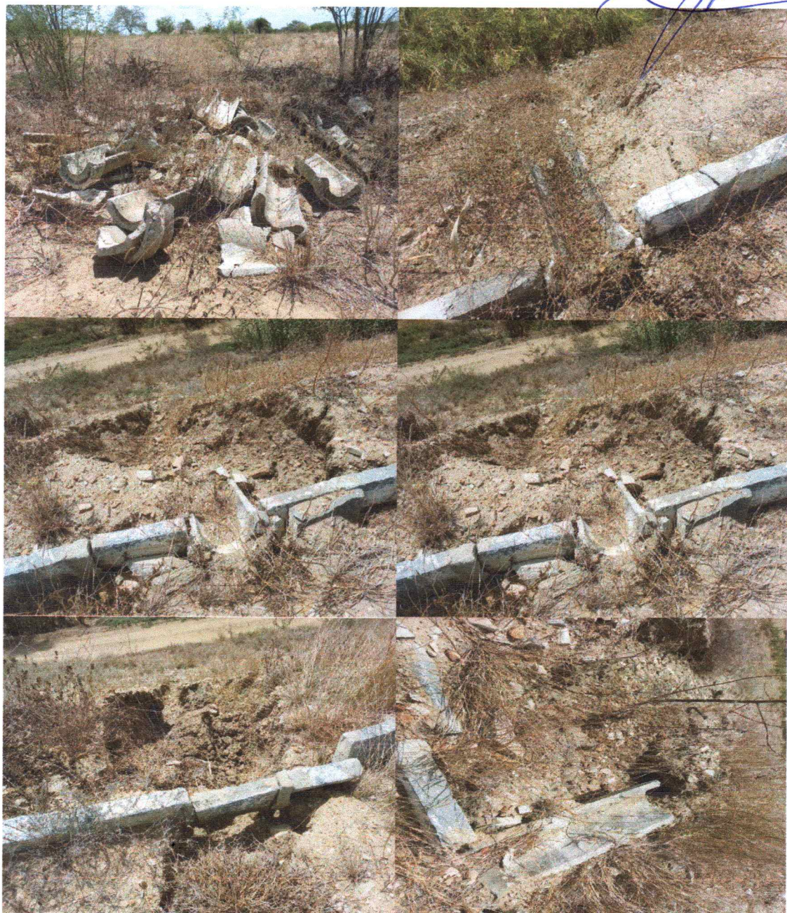
Situação do balde (10/12/2023).
